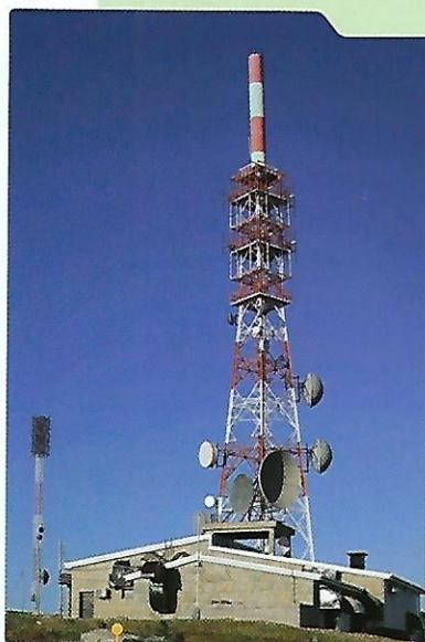
Antena transmisora de la señal de radio.
